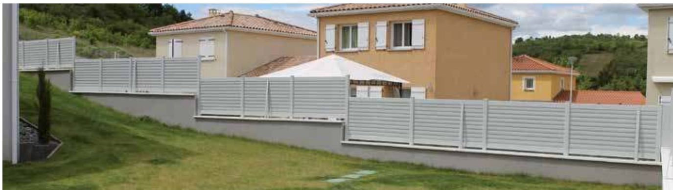
176 mètres linéaires de clôture brise-vent avec traverses (pose en escalier).
